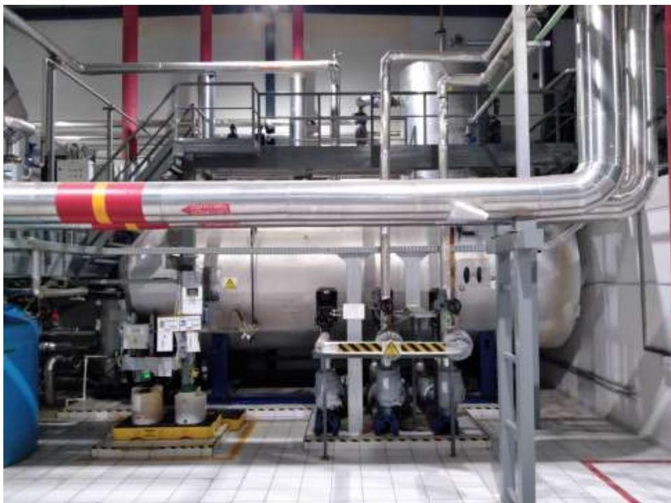
Рисунок 2.1.1 - Деаэрационная установка TDM-50 на объекте «AB InBev Efes»
