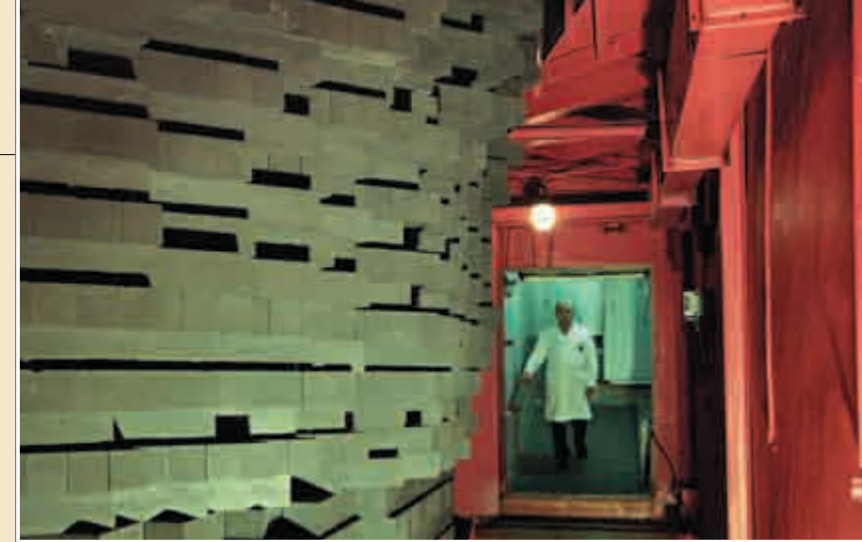
Графитовая кладка первого в СССР ядерного реактора Ф-1
