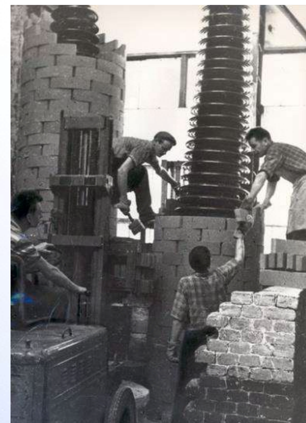
1967 г. Выгрузка изолятора из печи.
