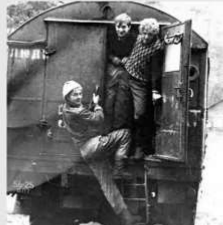
Ковалев Игорь о строительстве ЛЭП 35 кВ
