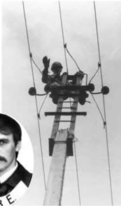
Монтаж ЛЭП 10 и 35 кВ. 1980 г.
